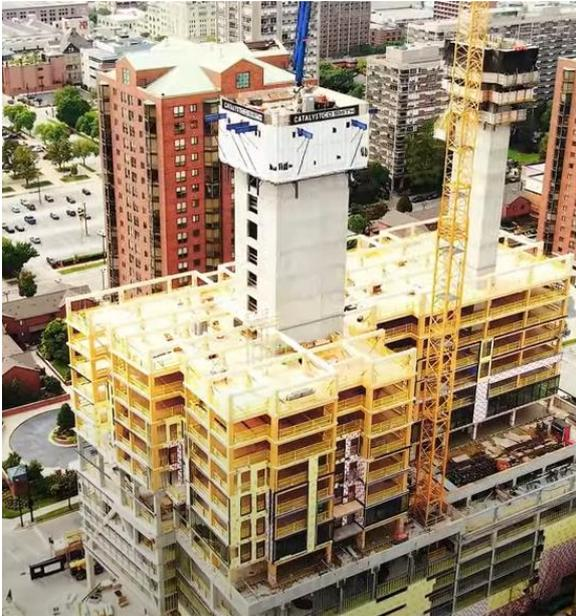
Op. no maderables 1: Muros de cortante de hormigón
