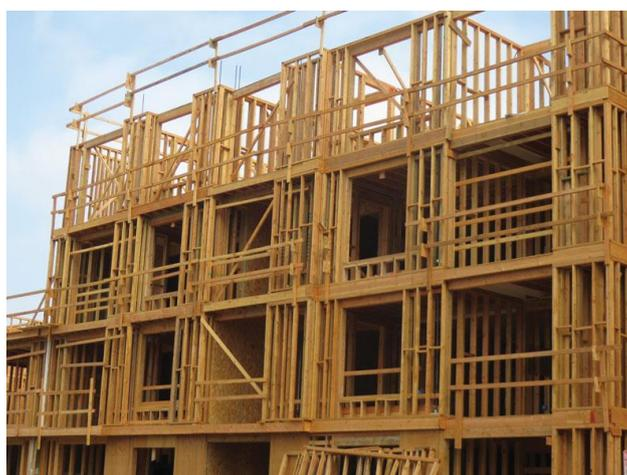
Progresivamente, los componentes de las estructuras ligeras se fabrican fuera de las obras y se ensamblan posteriormente en el lugar de construcción.
