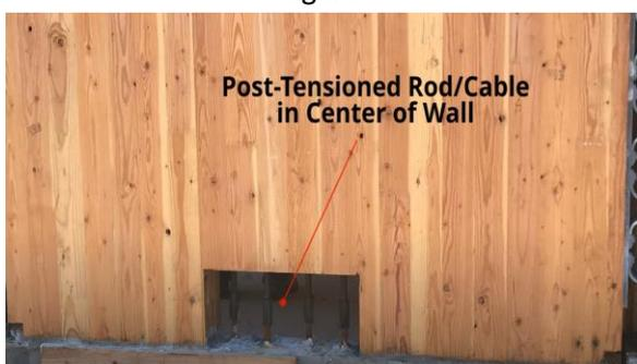
Madera op 3: Muros pantalla basculantes de madera maciza
