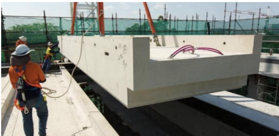
Figura 6: 1 de los 33 paneles GPC prefabricados (WAGNERS, s.f.)
