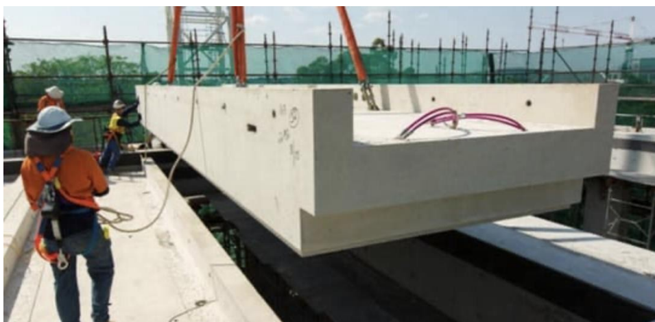
Figur 6: 1 av de 33 forhåndsstøpte GPC-panelene (WAGNERS, u.å.)
