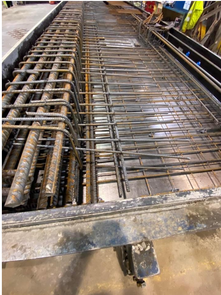
Vedlegg 35: Livefoto av forsterkning av en faktisk massiv modulvegg
