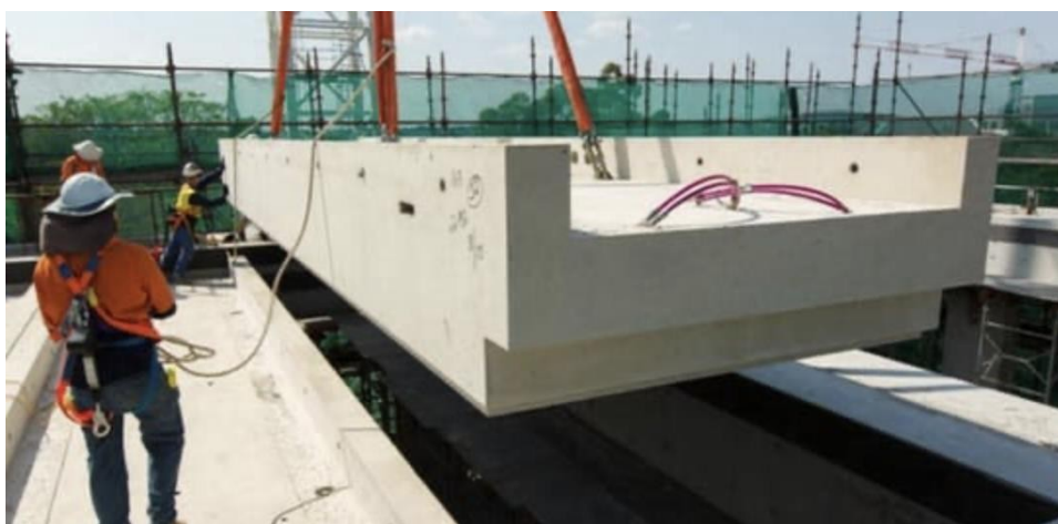
Figura 6: 1 din cele 33 de panouri GPC prefabricate (WAGNERS, n.red.)
