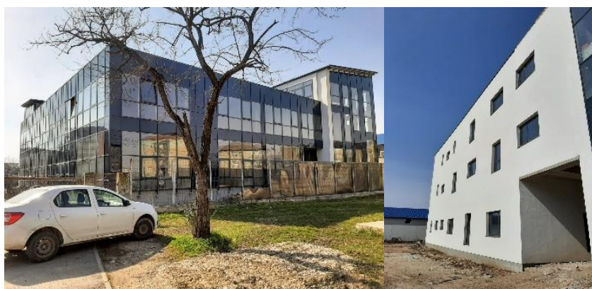
Figura 12 Concept proiect Ditoiu Nina-Cristina-fotografii 27.05.2021, Ditoiu Nina-Cristina, fatada Cortina urmeaza sa fie umbrita cu parasolare verticala, culoare Corian Alb, initial cu insertii color building + refurbishment
