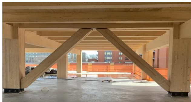
Timber op. 4: Avstivede rammer av massivtre
