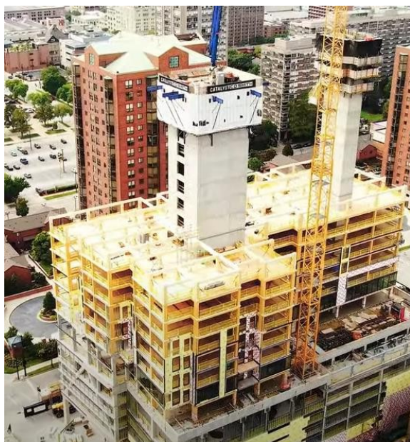
Ikke-tømmer op. 1: Skjærvegger av betong
