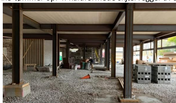
Ikke-tømmer op. 2: Stålavstivning/momentrammer
