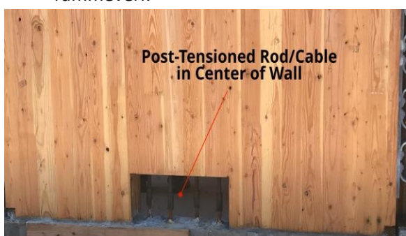
Tømmer op 3: Skjærvegger av massivtre som gynger
