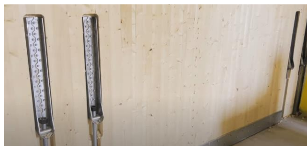
Tømmer op. 2: Skjærvegger av massivtre
