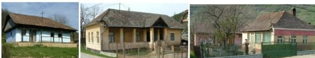
Figur 21 Det første bildet er en tradisjonell trearkitektur. Terrassen til huset med en sørlig orientering er et åpent rom. Terrassedekket beskytter inngangsdøren og vinduene mot overoppheting av solen
