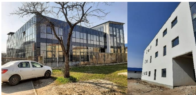
Figur 12 Prosjektkonsept Ditoiu Nina-Cristina-bilder 27.05.2021, Ditoiu Nina-Cristina, Gardinfasaden skal skyggelegges med vertikale solskjermer, Corian farge Hvit, i utgangspunktet med fargeinnsatser
